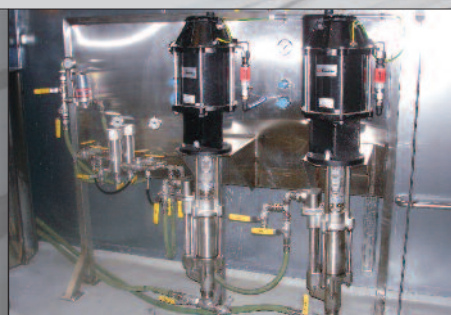
4х шаровые поршневые насосы с коэффициентом 4:1 установленный для формуляции красок.
