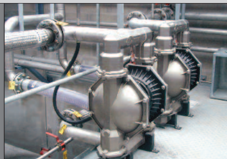
3" нержавеющие диафрагменные насосы, установленные для разгрузки материала из емкостей.
