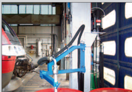
2х шаровой поршневой насос с коэффициентом 9:1 используется для подачи смазочных материалов.
